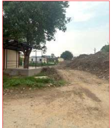
२२८९३० ३०५३९५५ १५३ भरतपुर २७/२५ सीमाना, बटारे खोला निर्माणाधीन पुल
